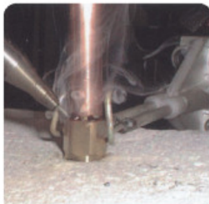
青紅銅管結合 Brass pipe fitting
